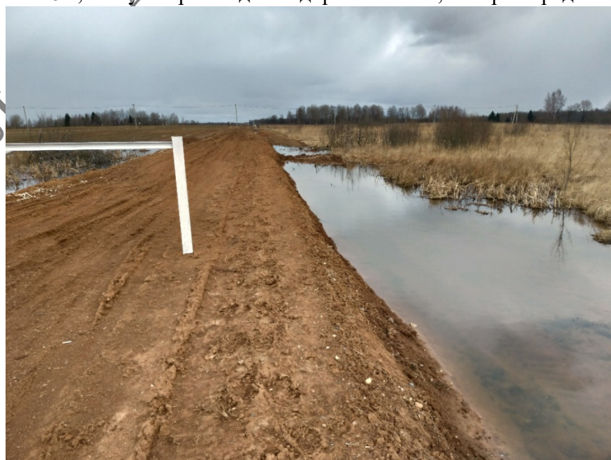
Пример 2. Насыпь 1.5м, на пути прохождения дороги болото, которое предстоит осушить
